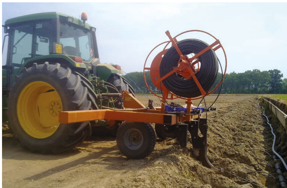
Fase di interrimento dell'impianto di subirrigazione.
